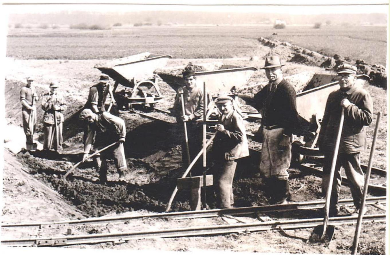
Abb. 5: Eine Arbeitsgruppe beim Ausheben von Gräben zur Entwässerung des Gebietes im Jahr 1952. Zusätzlich wurden in den feuchteren Bereichen noch Drainagen verlegt. (Text und Foto: O. Diehl)
